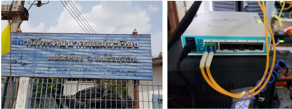
ภาพประกอบที่ 10. ติดตั้งอุปกรณ์ Mikrotik เพื่อวางระบบ Alarm ภายในชุมสายฯ
